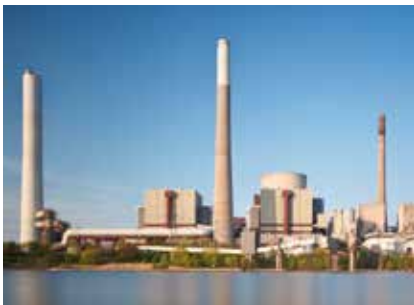
POWER GENERATION GENERACIÓN DE ENERGÍA
